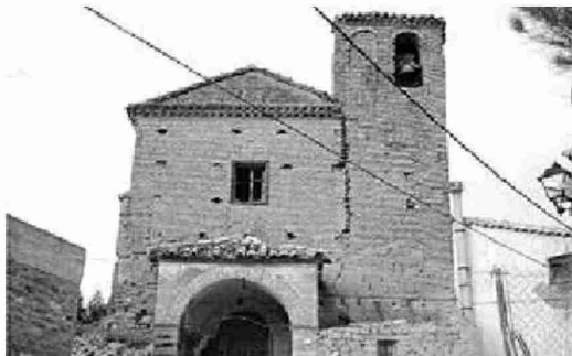
Imagen de la iglesia antes de que se desmontara la torre. S.E.
